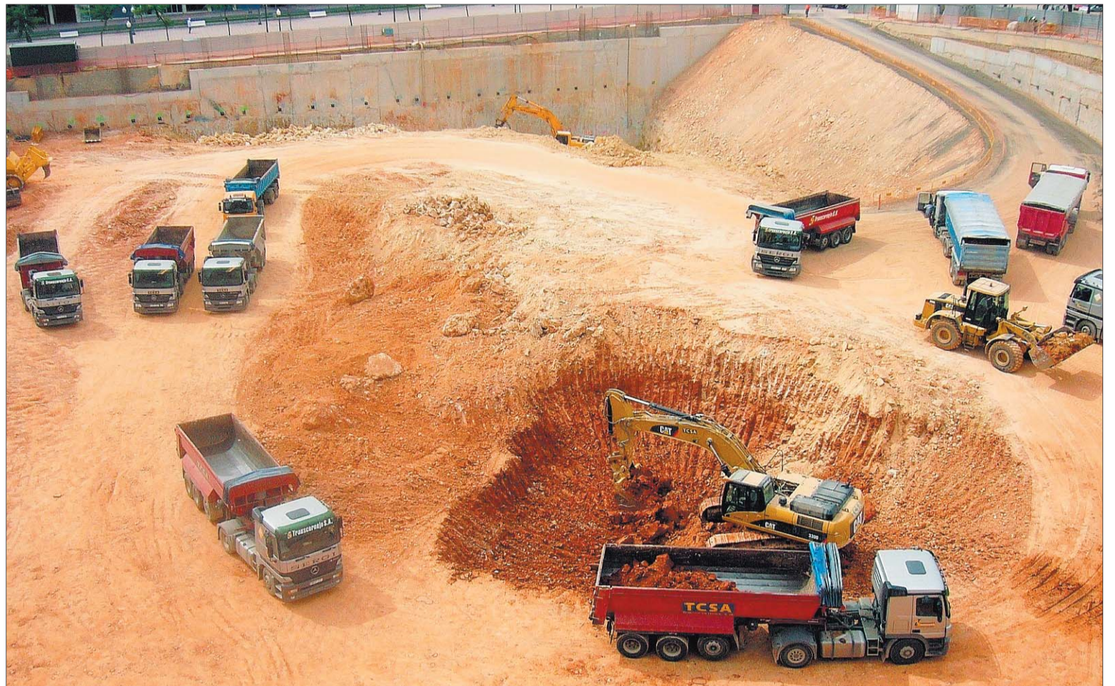
En la fotografía se observa el estado de las obras y siete camiones preparados para llevarse la tierra que se extrae del solar. FOTO: CARLES GOSÁLBEZ
